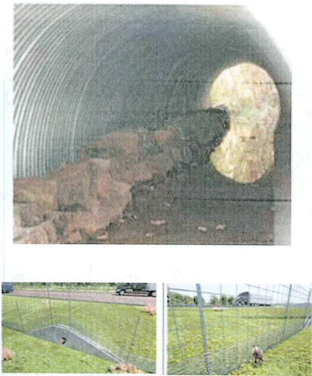
Imagen 14. Diseños pasos de fauna tipo alcantarilla
